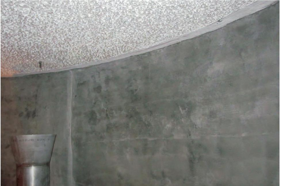
*Neu beschichtete Decke des Wassertanks mit Überlaufstutzen*
