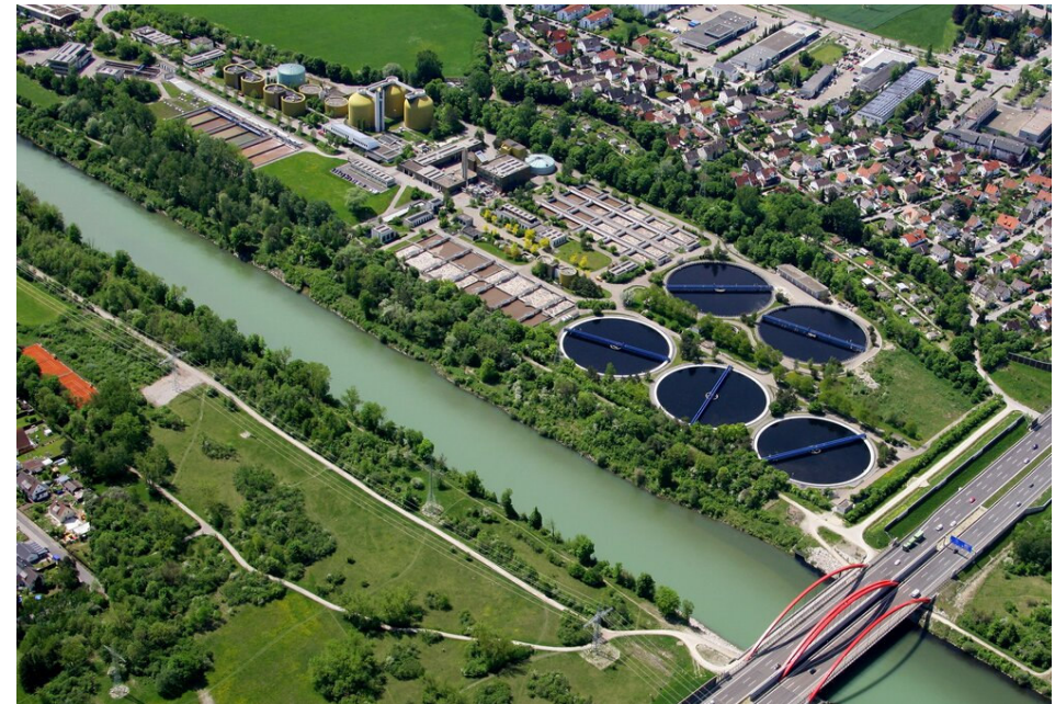
Kläranlage Augsburg – Luftbild
